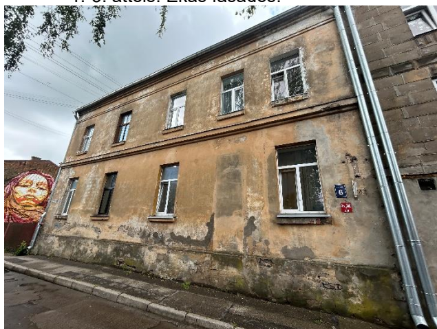
1.-3. attēls. Ēkas fasādes.
